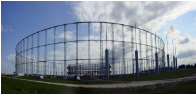
Flr-9 Demolition Day 2 - Source La Famiglia (SVASAA) web site
